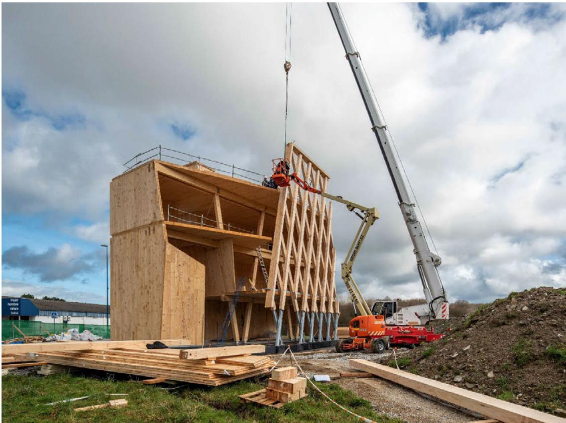
El edificio «Impulso Verde» es una alternativa a los modelos constructivos convencionales altamente contaminantes, basados principalmente en la construcción con materiales con gran energía incorporada, como el hormigón y el acero. La estructura de este edificio se construye completamente con madera de origen local, en concreto de la provincia de Lugo y con certificación de gestión forestal sostenible. En su construcción se utilizan los dos productos desarrollados en el marco de este proyecto
