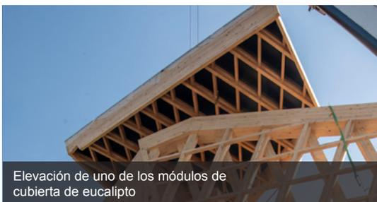
Elevación de uno de los módulos de cubierta de eucalipto
