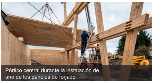
Pórtico central durante la instalación de uno de los paneles de forjado
