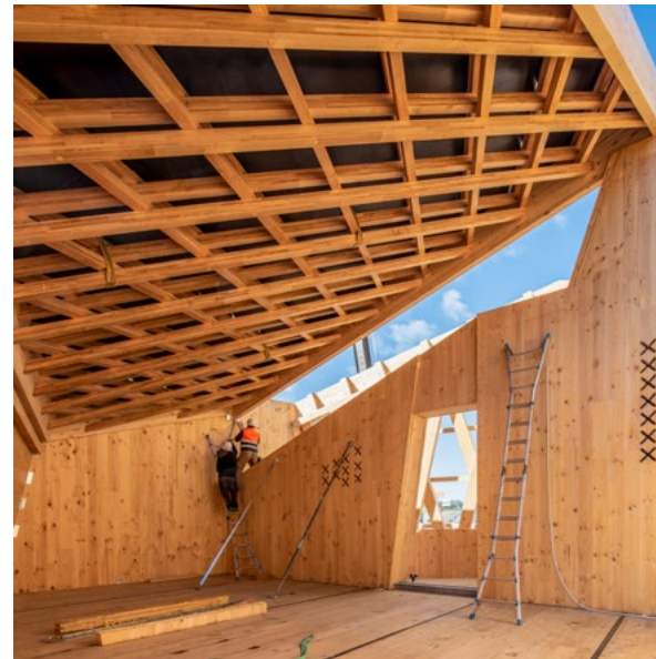
Sup. izq.: Pórtico central durante la instalación de uno de los paneles de forjado; Sup. dcha.: Instalación de ventilación en el muro técnico central; Inf. izq.: Elevación de uno de los módulos de cubierta de eucalipto; Inf. dcha.: Ajuste de la cubierta durante el montaje.
