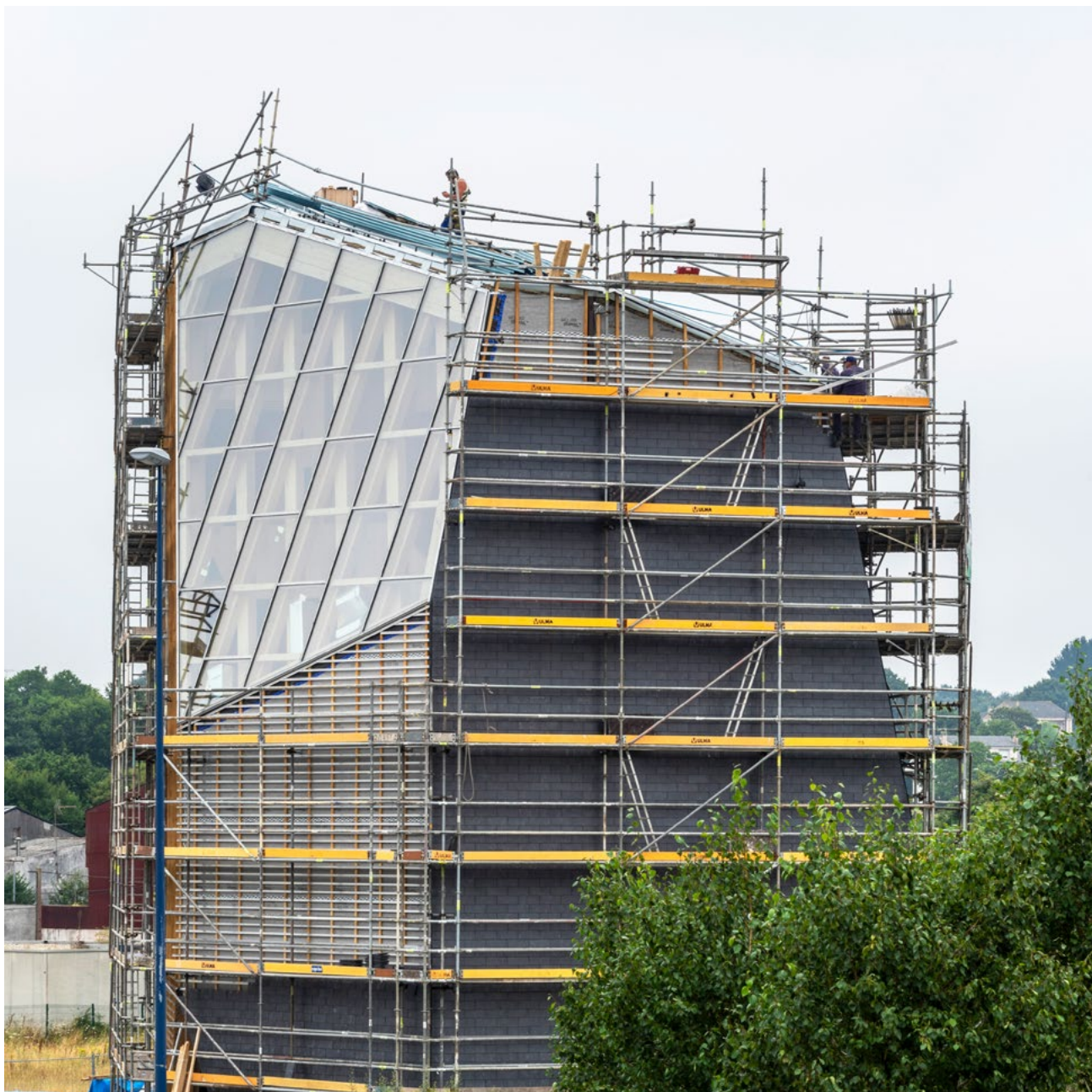
Estado de la obra el 22/07/2021. Ejecución de la fachada ventilada.
